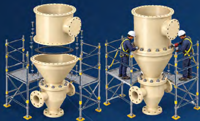
TK-210 · MONTAGEM E APARAFUSAMENTO CILINDRO-CÔNE
