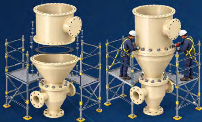
TK-210 · MONTAJE Y EMPERNADO CILINDRO-CONO
