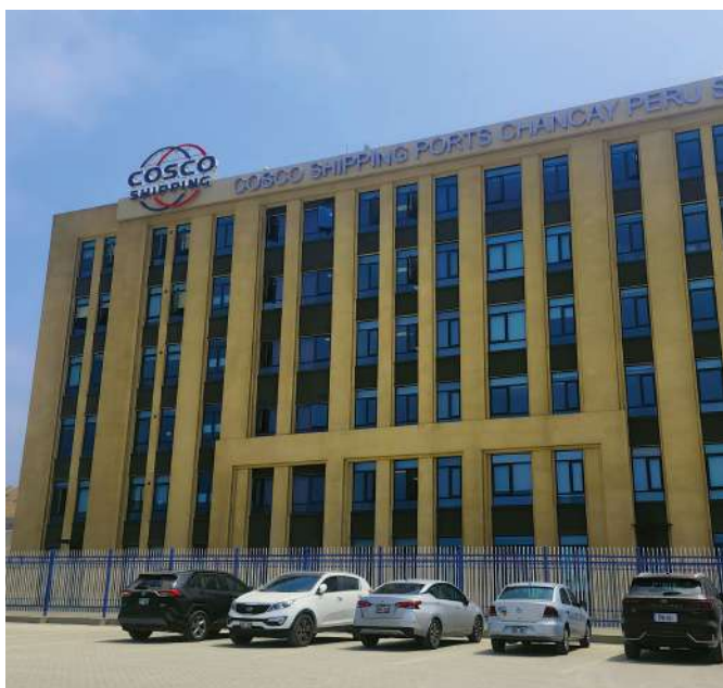
Figura nº 02: Prédio administrativo da Cosco Shipping Ports Chancay Perú S.A.
