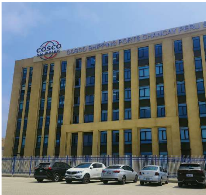
Edificio administrativo de Cosco Shipping Ports Chancay Perú S.A.
